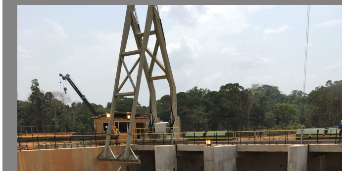
Dégrilleur à râseau de 20 tonnes et d'une portée de 15 m fourni à HPP pour une centrale hydroélectrique en République Démocratique du Congo
