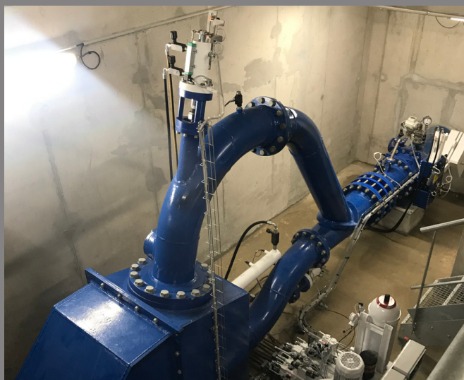
Turbine Pelton verticale 4 jets de 420 kW en France (Lozère)
