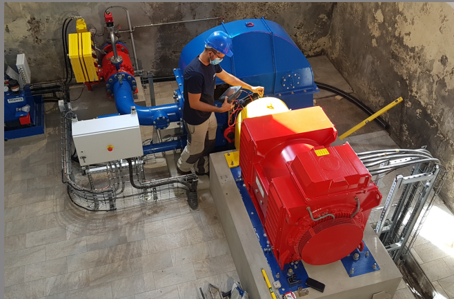
Turbine Pelton horizontale 1 jet de 330 kW en France (Savoie)
