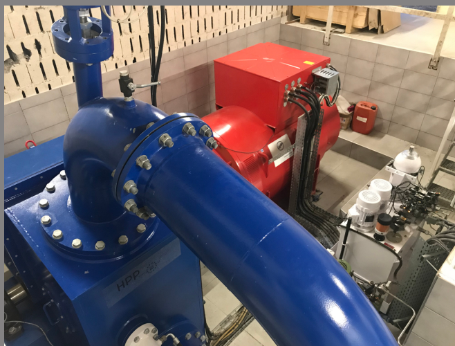
Turbine Pelton horizontale 2 jets de 450 kW en France (Rhône-Alpes)
