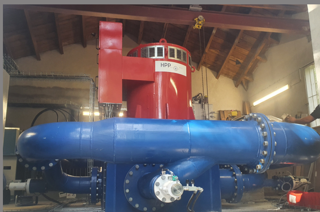
Turbine Pelton verticale 4 jets de 420 kW en France (Lozère)
