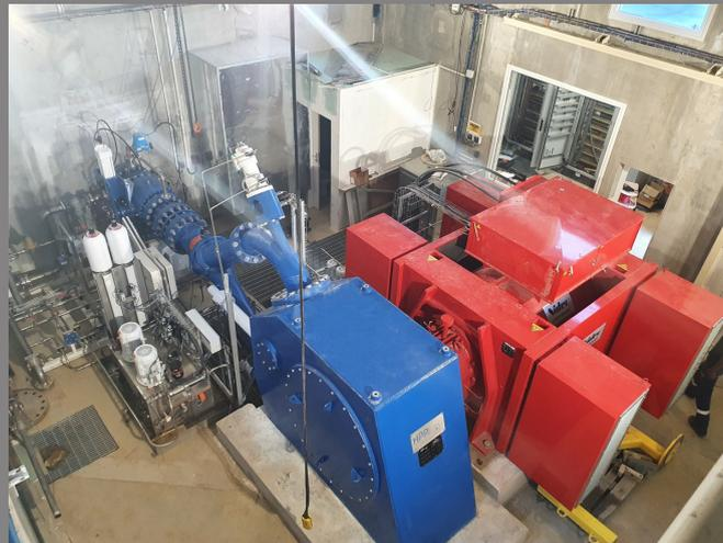
Turbine Pelton horizontale 2 jets de 3 MW sous plus de **500 m de chute**, en Nouvelle Calédonie.
